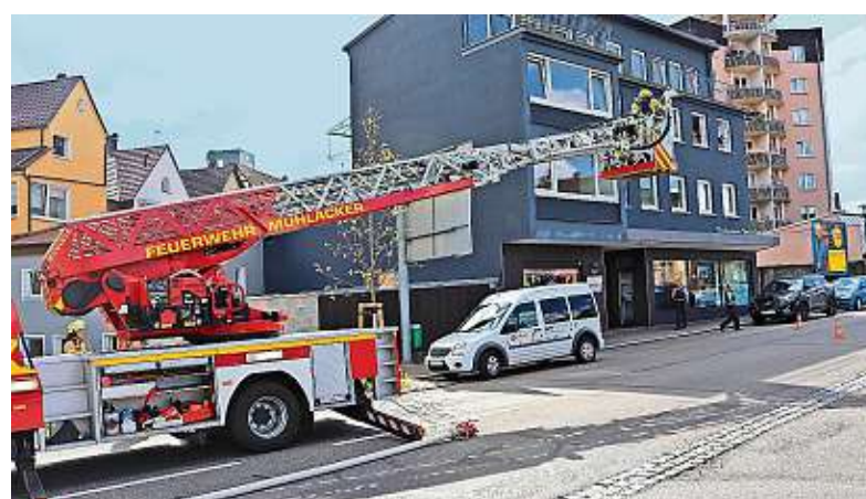
Ein Feuer auf dem Balkon eines Mehrfamilienhauses in der Mühlacker Bahnhofstraße hat gestern die Feuerwehr auf den Plan gerufen.
