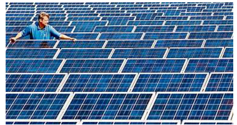
Energiewende rückwärts: Die aktuelle Gesetzeslage könnte dafür sorgen, dass Fotovoltaik-Anlagen von Dächern verschwinden, obwohl sie noch über Jahre Strom liefern könnten. FOTO: PLEUL/DPA-ARCHIV
